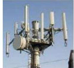
Il rendimento complessivo della Stazione Base, in termini di potenza assorbita dall'alimentazione in relazione con la sua potenza di uscita in radio frequenza (RF), è governato dal consumo di ogni suo singolo componente:
